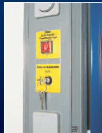
Feuermelder / Schlüssel-schalter Zum manuellen Auslösen der Löschanlage von Hand sowie Zusatzeinrichtungen für Sonderfunktionen
